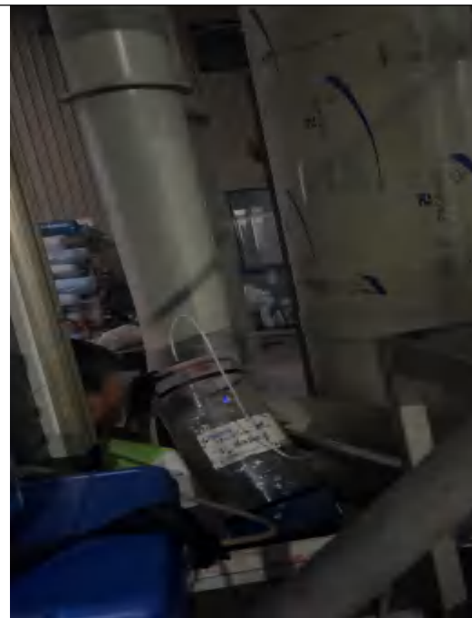
废气处理装置入口采样
