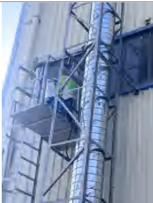
废气排放口采样
