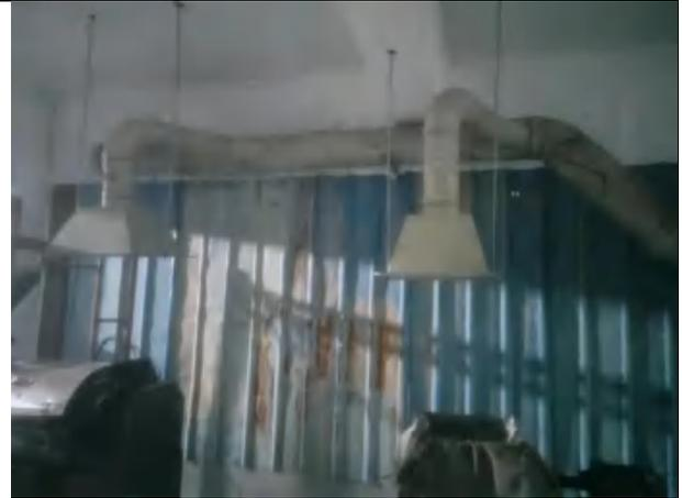
投料、混料废气 DA001 集气罩
