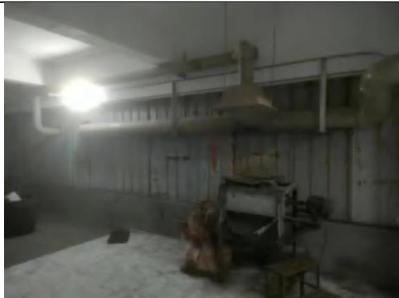
投料、混料废气 DA001 集气罩
