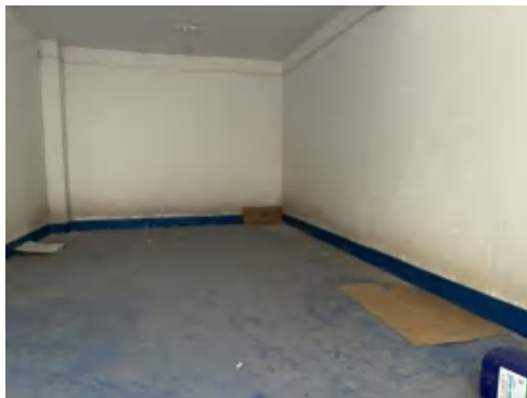
一般固体废物暂存间
