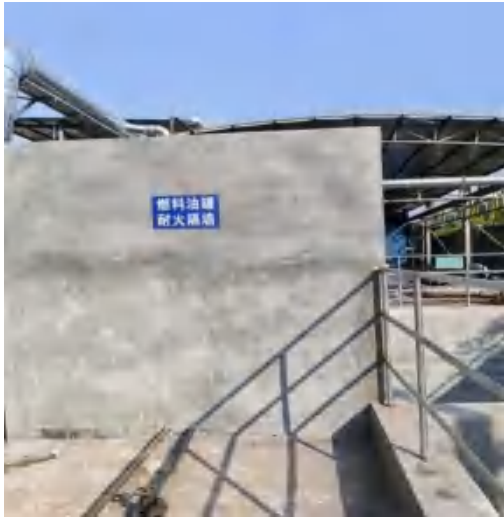
柴油储罐围堰
